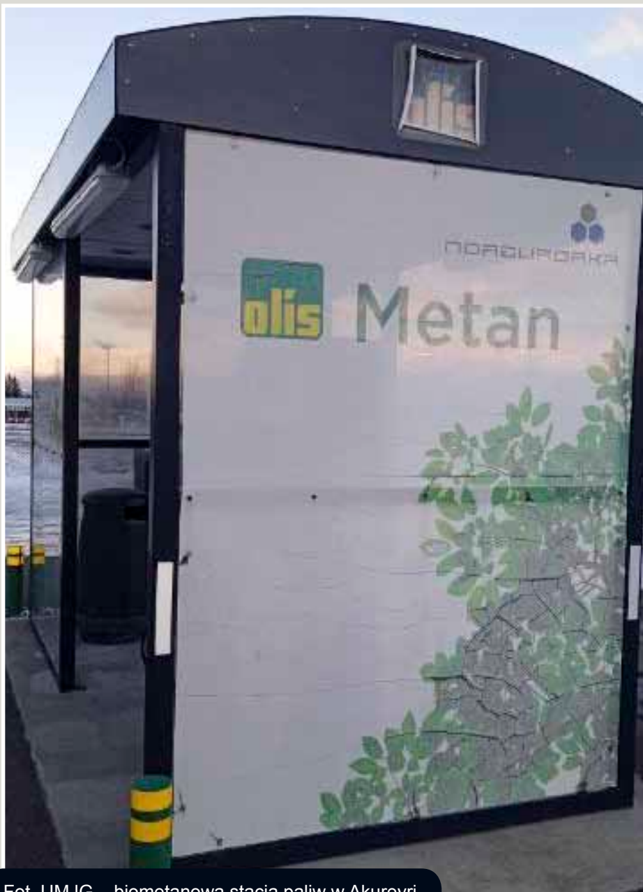
Fot. UMJG – biometanowa stacja paliw w Akureyri
